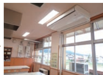
▲小中学校特別教室エアコン設置事業
