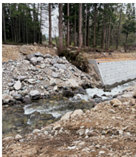
▲破損したスポーツパーク松原湖の木橋
